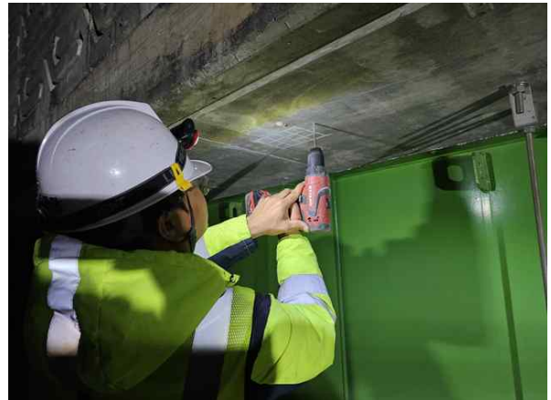
탄산화깊이 측정 현황
